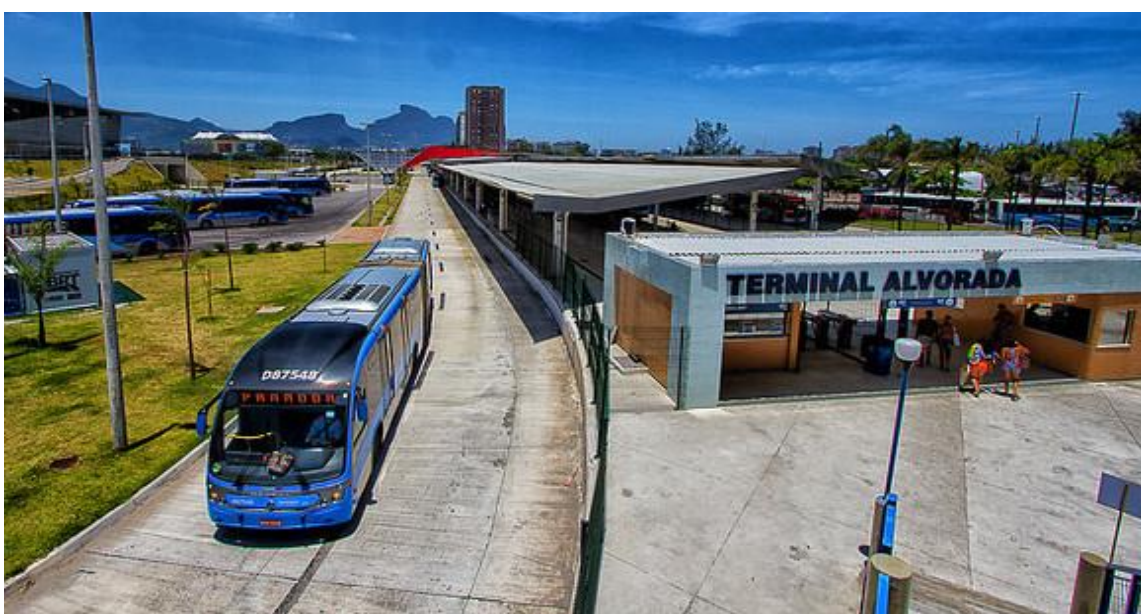
( Imagem 4 ) Foto do Terminal Alvorada, Barra da Tijuca. Fonte :PAC, Ministério do Planejamento. Disponível em:< http://www.pac.gov.br/noticia/c13ebba8 > Acessado em 26 de maio de 2016.
